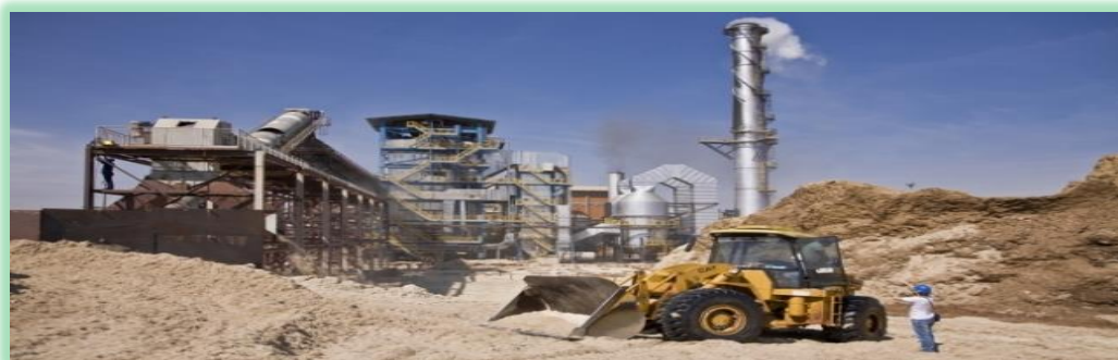
Usina sucroenergética utilizando o bagaço de cana para gerar bioeletricidade
